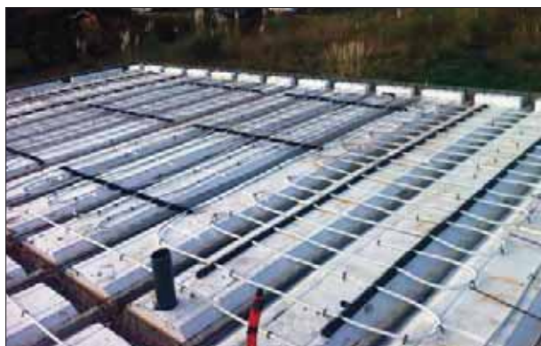
5. Pose des panneaux treillis soudés
