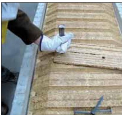
Séparation du tympan pour rupteur ES
