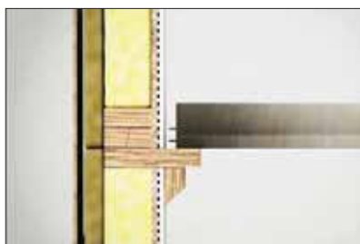
Pose des Poutrelles sur corbeaux
