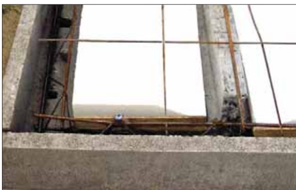
Plancher Hourdis Seacbois Rupteur Partiel : Stoptherm ES
