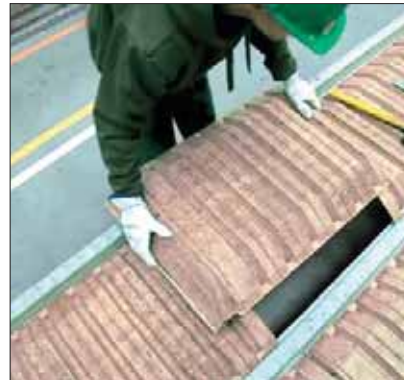
Ajustement dans sa longueur Toujours couper le bouchon sur l'EBS d'ajustement qui vient en recouvrement sur les 2 autres
