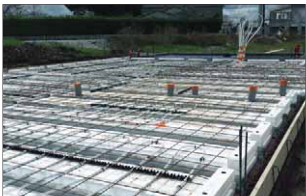
5. Pose des panneaux treillis soudés
