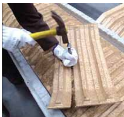
Coupe au burin ou au marteau (sécable)
